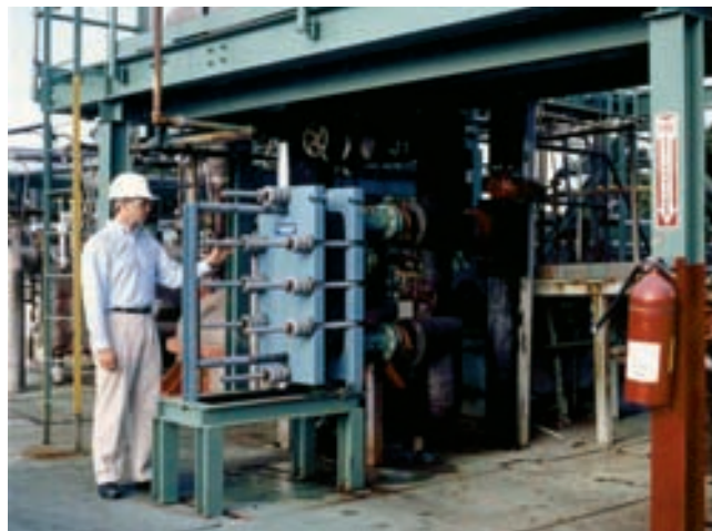
Пластинчатый теплообменник DIABON® Альфа Лаваль с пластинами из материала F100, используемый для охлаждения смеси соляной кислоты и хлорированных углеводородов на одном из американских заводов
