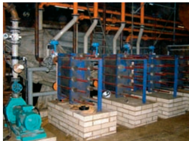
Пластинчатые теплообменники DIABON® Альфа Лаваль с пластинами из материала NS1, используемые для охлаждения травильной кислоты, применяемой для обработки нержавеющей стали, на одном из немецких сталеплавильных заводов.
